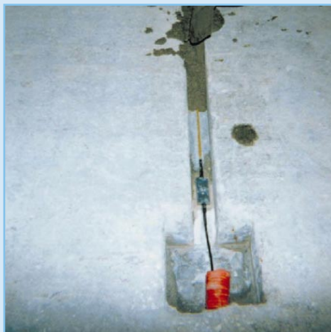
Corde optique scellée ultérieurement dans une saignée.
