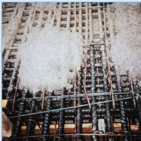
Corde optique pendant le bétonnage.
