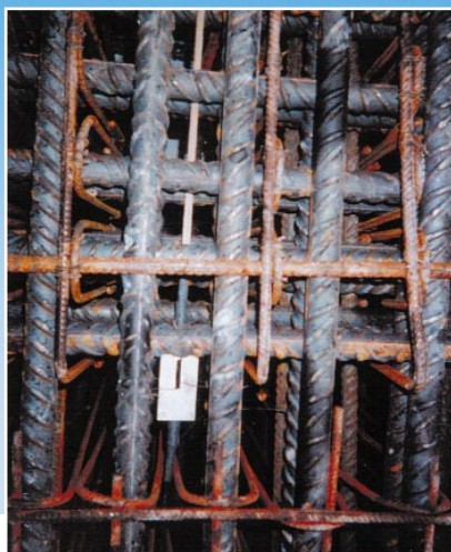
Corde optique dans une cage d'armature.
