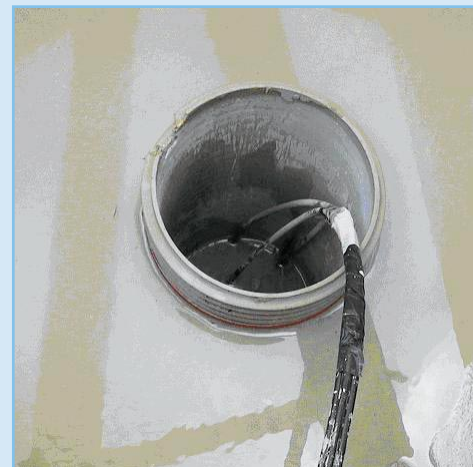
Corde optique dans un forage injecté.
