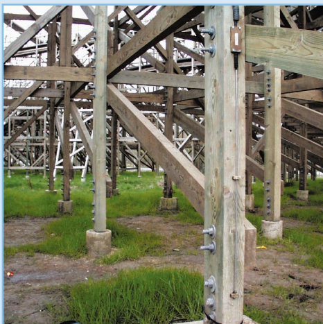
Extensomètre sur une construction en bois.
